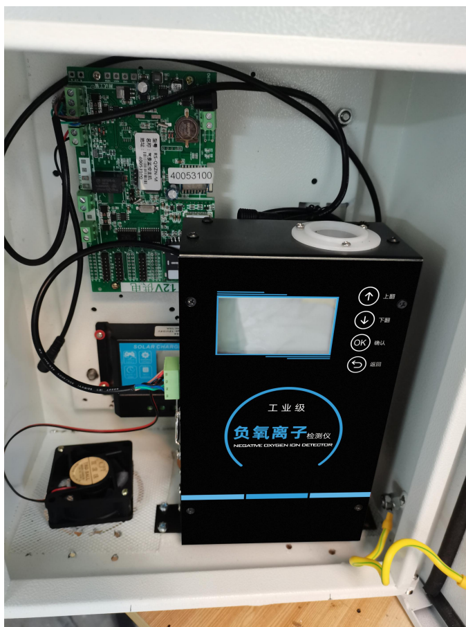
安装完成正面图
