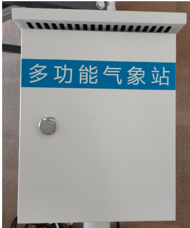
安装完成正面图
